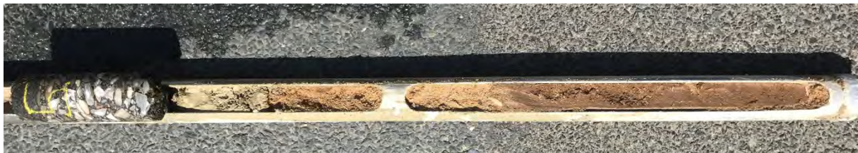
Bild 4: Asphaltkern KB 5, mit ungebundener Tragschicht, Sandauffüllung (RKS 5)
