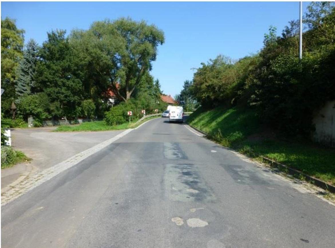
Abbildung 7: Fehlender Schichtenverbund der Asphaltdeckschicht im Bereich Bau-km 1+030
