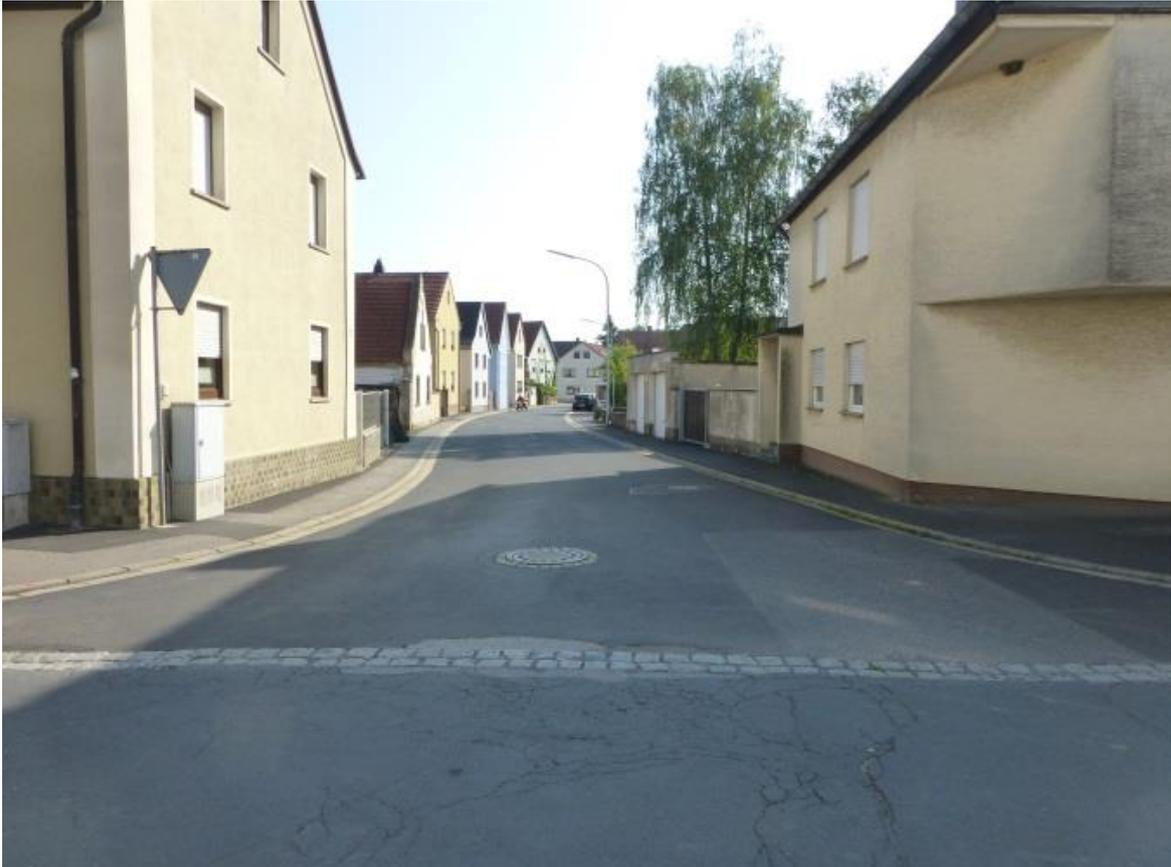
Abbildung 3: Netzrisse und verdrückter Fahrbahnübergang bei Bau-km 0+425
